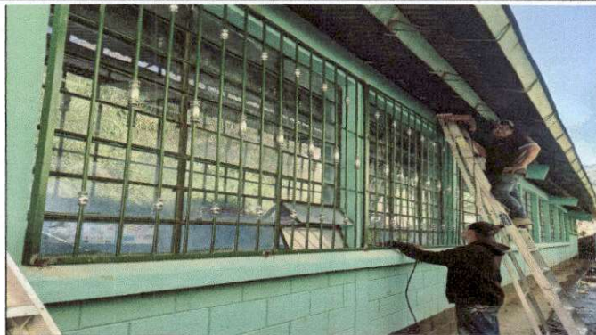
Foto 2: Instalación de balcones de hierro en ventanas
