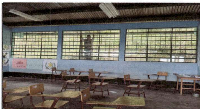
Foto 6: Instalación de balcones de hierro en ventanas
