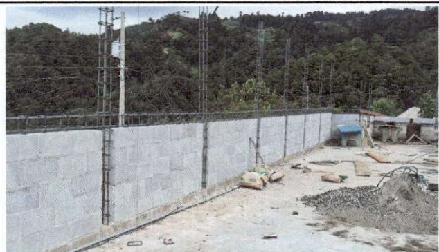
Foto1: Reparación de muro perimetral de blocc con tubo HG y malla galvanizada, soleras intermedias y columnas.
