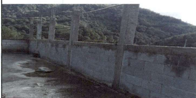
Foto 3: reparación de muro perimetral de blocc con tubo HG y malla galvanizada, soleras intermedias y columnas.
