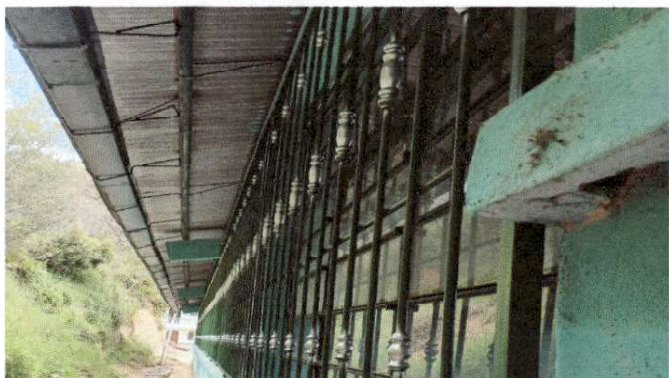
Foto 4: Instalación de balcones de hierro en ventanas
