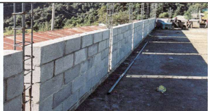
Foto 5: reparación de muro perimetral de blocc con tubo HG y malla galvanizada, soleras intermedias y columnas.
